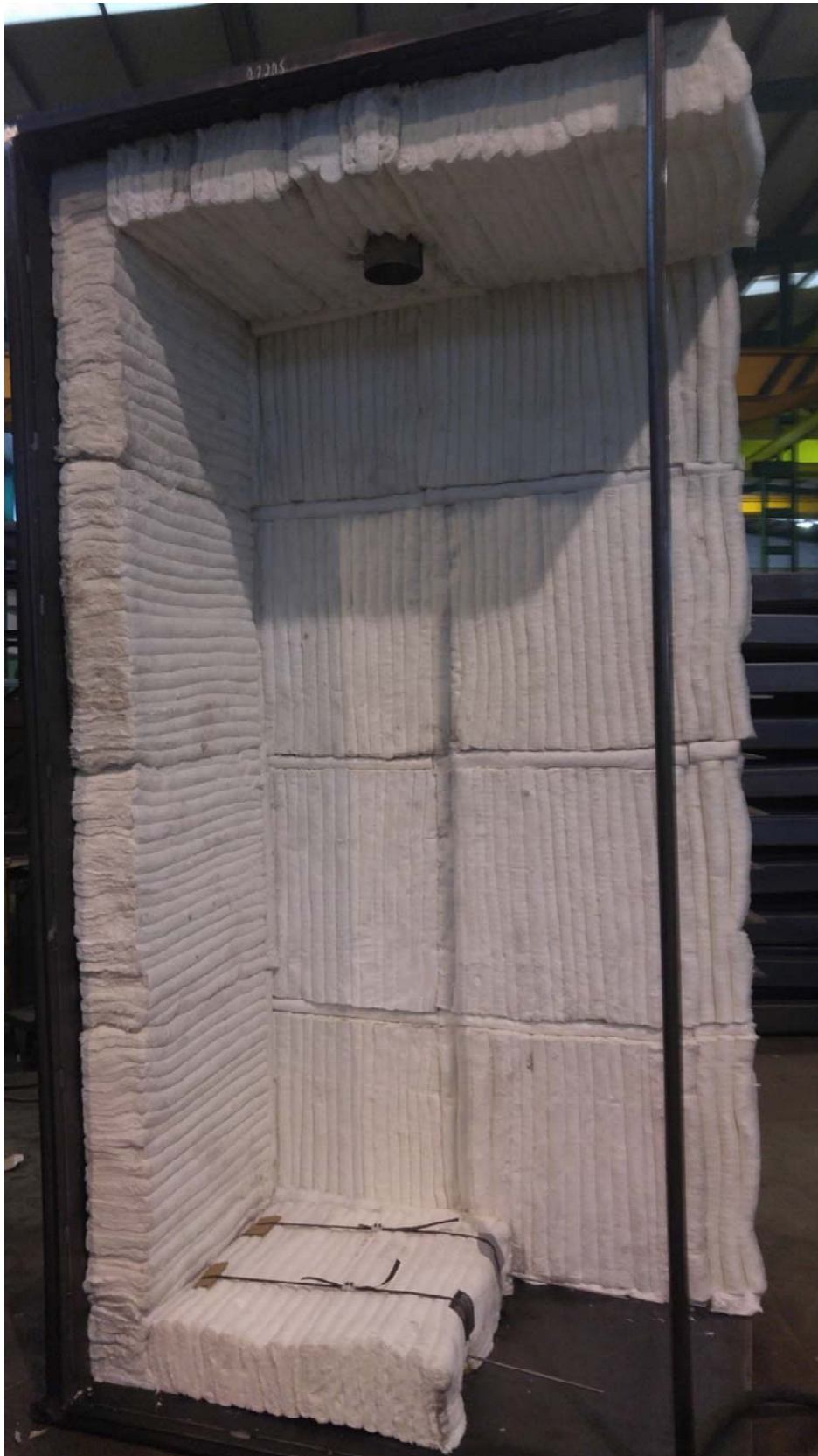
Fotografía 15: Aislamiento con fibra cerámica colocada en modo "stack bond".
