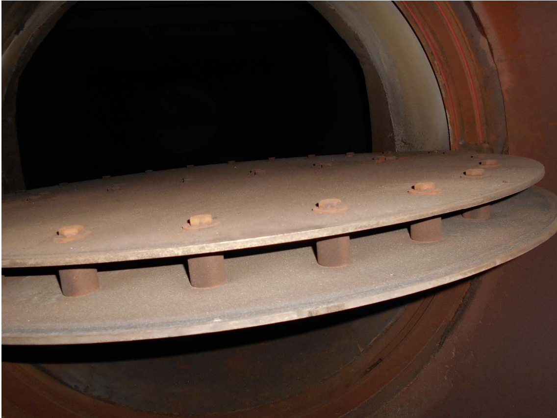
Fotografía 18: Válvula de mariposa de doble clapeta.
