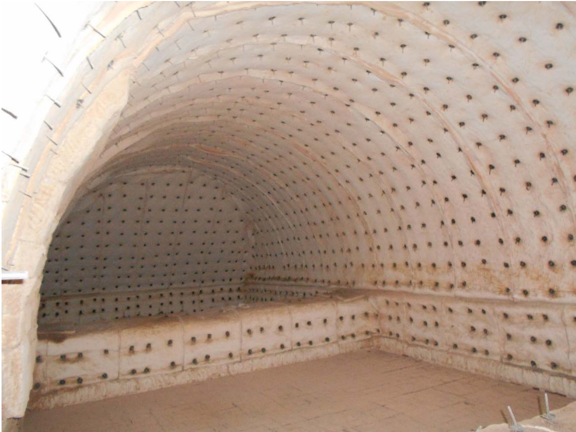
Fotografía 11: Cámara de oxidación aislada con fibra cerámica colocada en capas.
