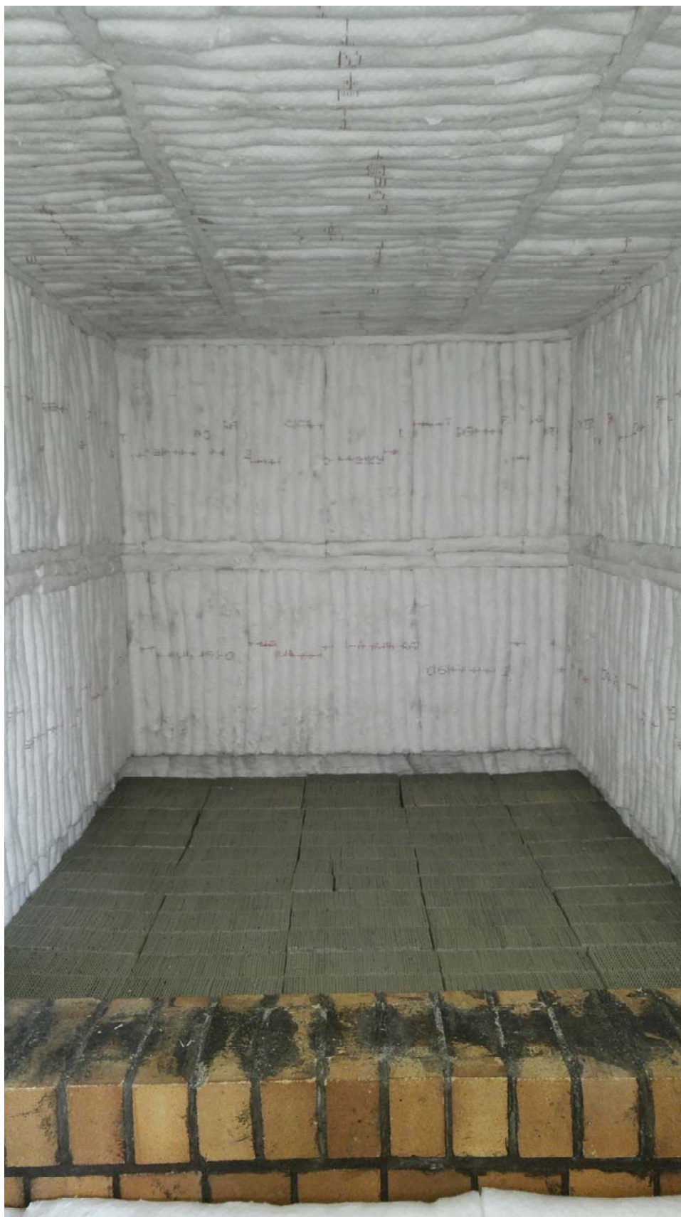
Fotografía 13: Aislamiento con fibra cerámica colocada en forma de libro.
